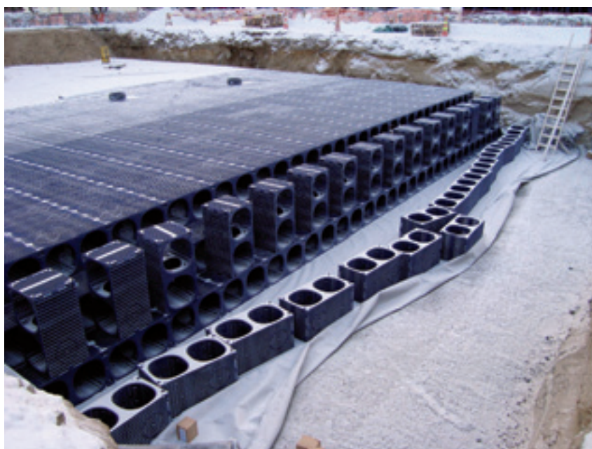
Kuva 3. Hulevesikasetteja asennusvaiheessa Kouvolan keskuspuistossa (Alue 2).
