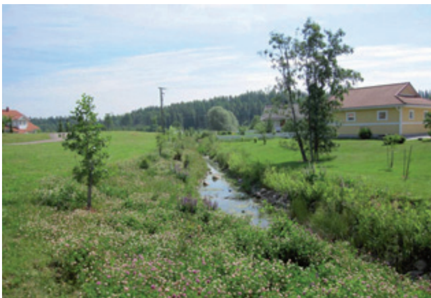
Kuva 2. Kilsoin uoma ennen sekä kunnostuksen aikana ja sen jälkeen.
