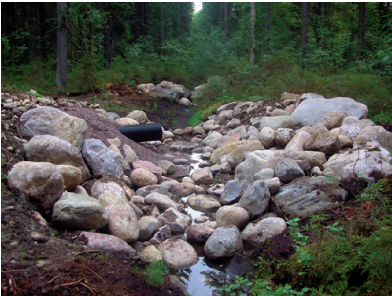
Kuva 6. Purkupaikan eroosiosuojauks ja viivyttämistä varten rakennettu kivikko (Kuva: Anniina Pouta).
