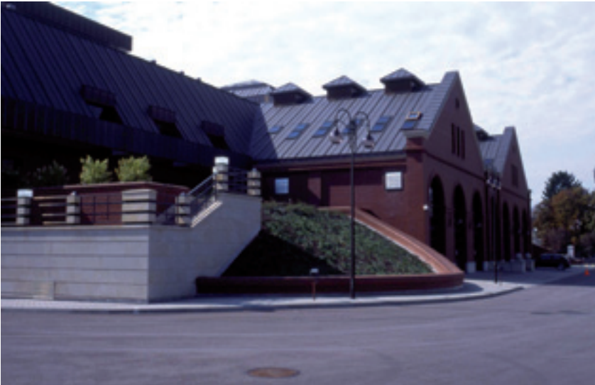
Otsonointi- ja aktiivihiilisuodatuslaitos sulautuu hyvin arkkitehtuuriltaan vanhaan rakennuskantaan. Kuva: Katriina Etholén.
