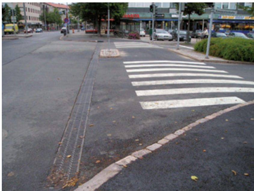
Kuva 2. Korotettu suojatjie Alueella 1.
