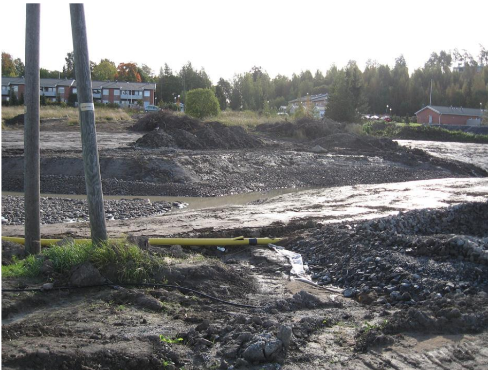
Hulevesiuoman rakentamista, Nuolialanlaakso Pirkkala. (Kuva: Tiia Helvilä)
