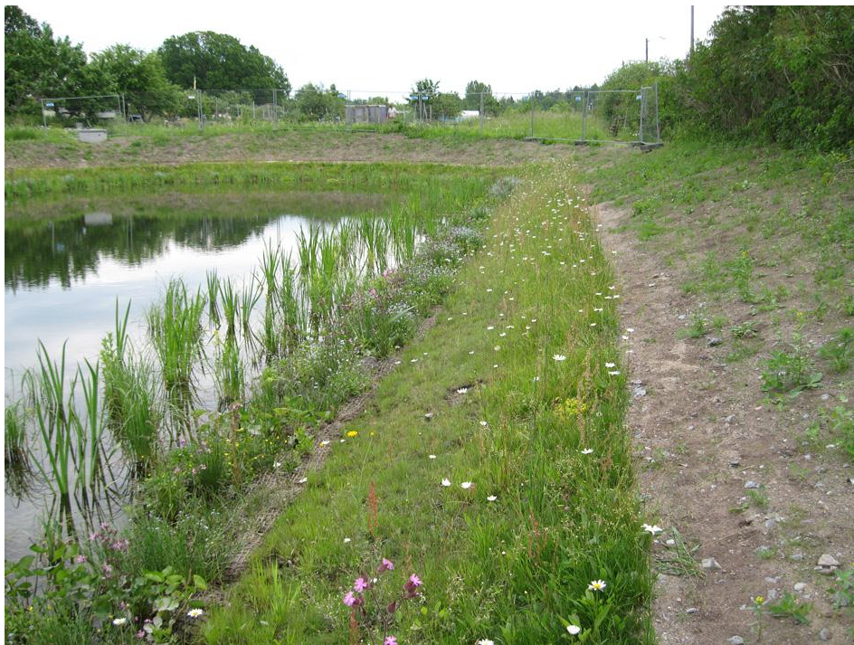
Kuva 7. Valmiit kasvillisuusmatot asennettuna hulevesialtaan reunaan. (Kuva: Taina Suonio, Envire, VRJ Group / Veg Tech)
